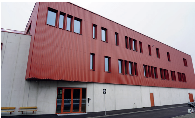
Ytterveggene mot øst og nord er delvis kledd med røde fasadeplater av stål.
