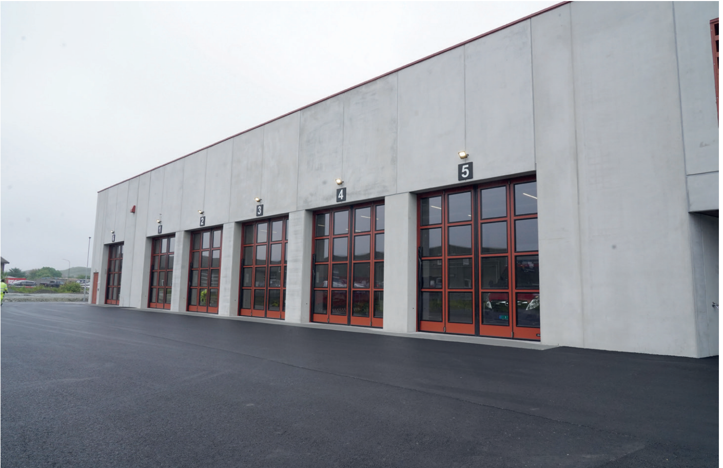
Bak disse seks portene skjuler det seg oppstillingsplass for fem større utrykningskjøretøy og en vaskehall.
